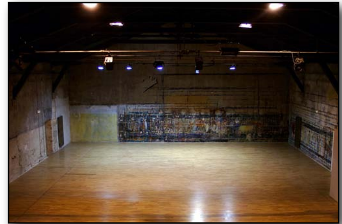
Mur du fond depuis la mezzanine
